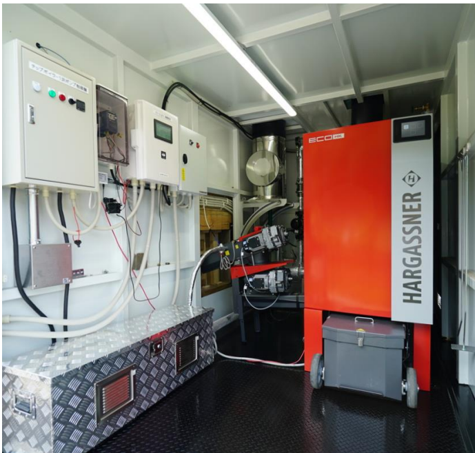
コンテナ内にボイラから1次側の熱交換器までの配管を取り付けた状態で出荷するため、現場の施工が短期間で完了します。
