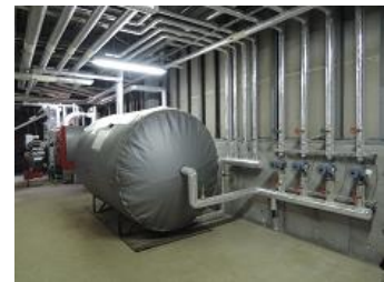
チップボイラや貯湯槽は既存のボイラ室に納めました。ボイラの稼働状況や燃料残量の通知のために遠隔監視オンサイトを導入しました。
