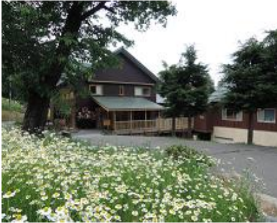
社員の保養所として作られた建物が地域の木材を用いた環境の宿としてリノベされました。
