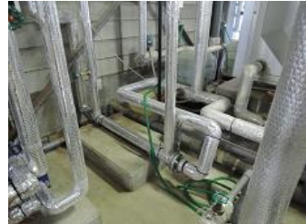
昇温用の小型の灯油ボイラ2台は撤去して、熱交換器に置き換えました。サイロはコンテナ式を採用しました。
