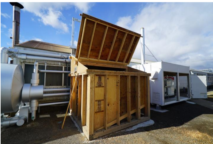
小型の木製サイロ。チップはバケットローダで上部から投入します。開閉は手動のウインチ。
