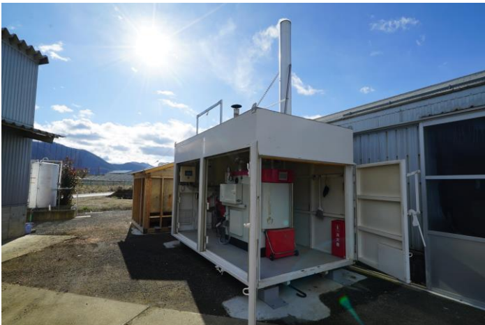
ボイラ室は鉄製のコンテナ方式。どのような現場でもコンパクトに収まります。
