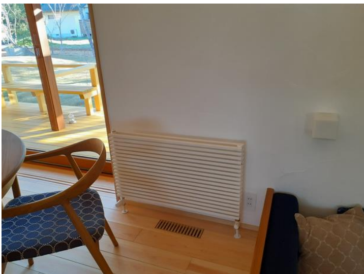
4枚の温水パネルから放熱することで屋内を暖房しています。お風呂とシャワーもボイラの温水です。
